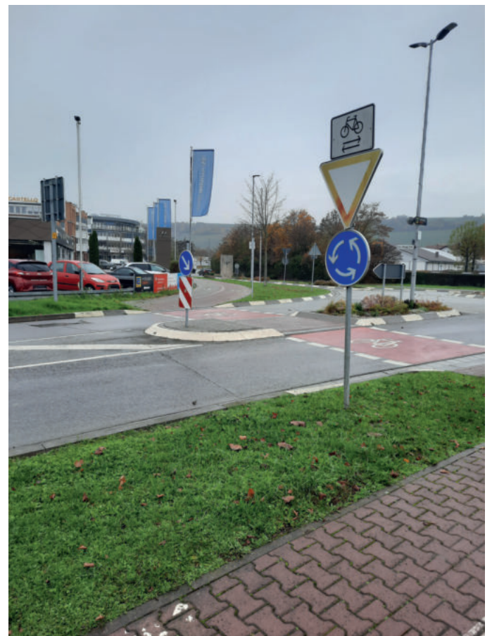
Neue Farbmarkierung für die Radwegequerung am Gutleutkreisel
