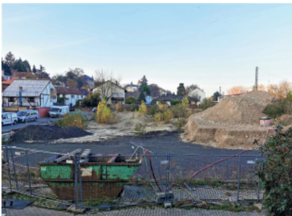
Das ehemalige Gradinger-Gelände - Baustart wahrscheinlich im Oktober
