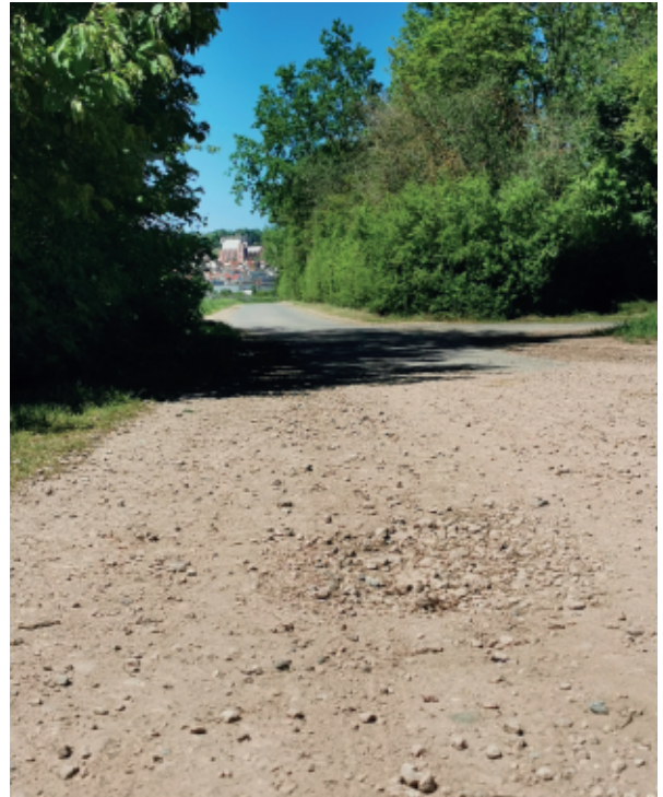
Die Schotterstrecke ab Segelflugplatz soll ausgebaut werden
